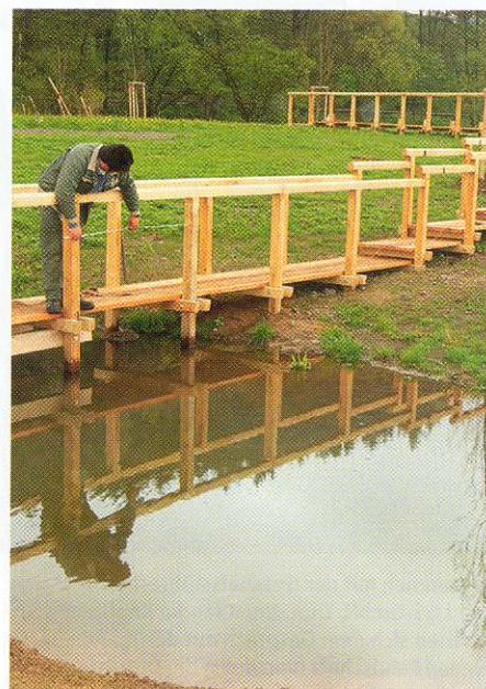
Dreiarmiger Holzsteg als Teil des Hauptweges, der vom Besucherparkplatz zum südlichen Gartenschau-Eingang führt. Eichenholz gehobelt, auf einem Meter Tiefe mit dem Erdlochbohrer vorgebohrt und mit Betonummantelung gesetzt.
