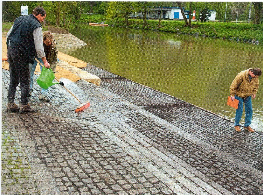
Auch die so genannte Floßblende ist Teil eines Loses der Firma Majuntke. Die Fugen des Natursteinpflasters sind mit Extensiv-Dachsubstrat verfüllt. Kokosmatten im Hintergrund decken eine Rasensaatfläche ab. Hier ist absoluter Hochwasserbereich.
